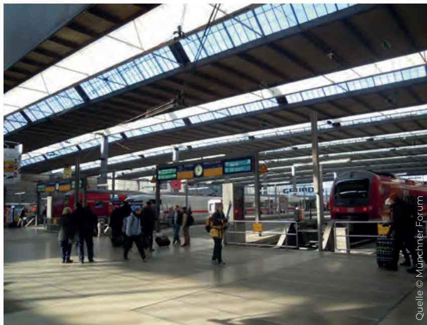
Bahnhofshalle des Münchner Hauptbahnhofs
