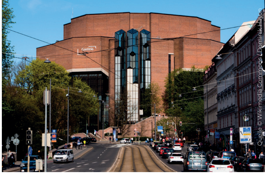
Der sanierungsbedürftige Gasteig in München
