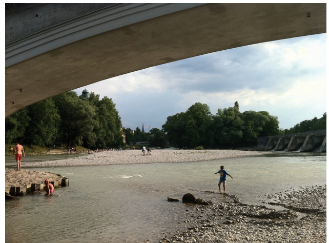
Unter dem Kabelsteg
