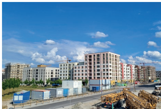
Freiham in der Bauphase 2023
