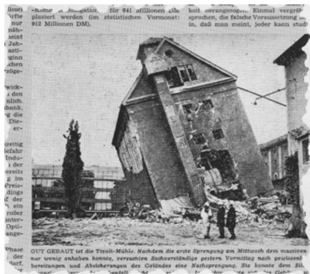
Sprengung der Getreidemühle 1969
