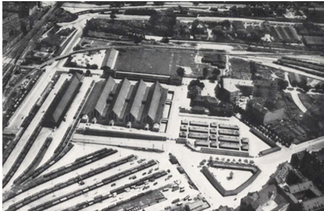
Der Münchner Großmarkt um 1927. Gegenüber der Gastwirtschaft Großmarkthalle wird gerade das Kontorhaus errichtet. Stadtarchiv München, DE-1992-FS-PK-STB-10289
