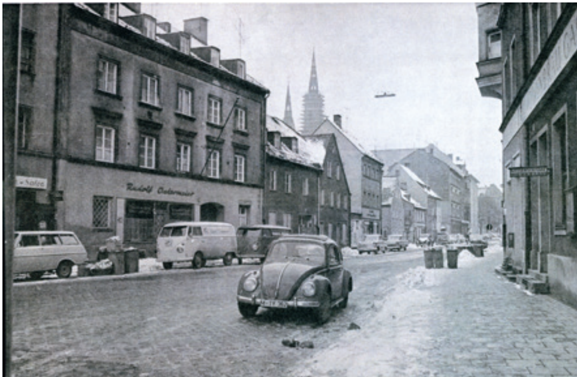
Ein Blick in die heterogen bebaute Kirchenstraße in Haidhausen, um 1970 Archiv der Münchner Gesellschaft für Stadterneuerung MGS
