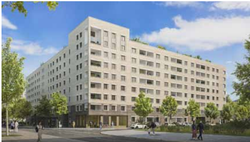
Auf dem GWG-Baufeld WA12 in der ehemaligen Bayernkaserne entstehen rund 190 geförderte Wohnungen.
