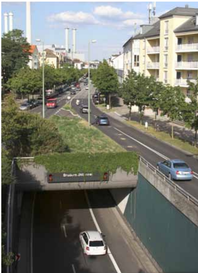
Westportal des Brudermühltunnels und Oberflächenfahrbahnen. Im Hintergrund das Heizkraftwerk Süd.
