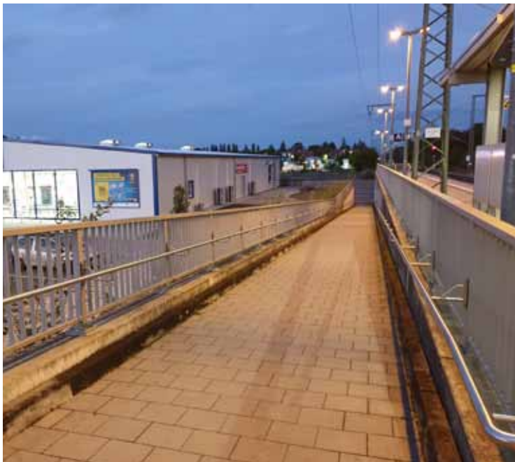
Nicht rollstuhlaugliche Rampe: zu steil und ohne Zwischenpodest.
