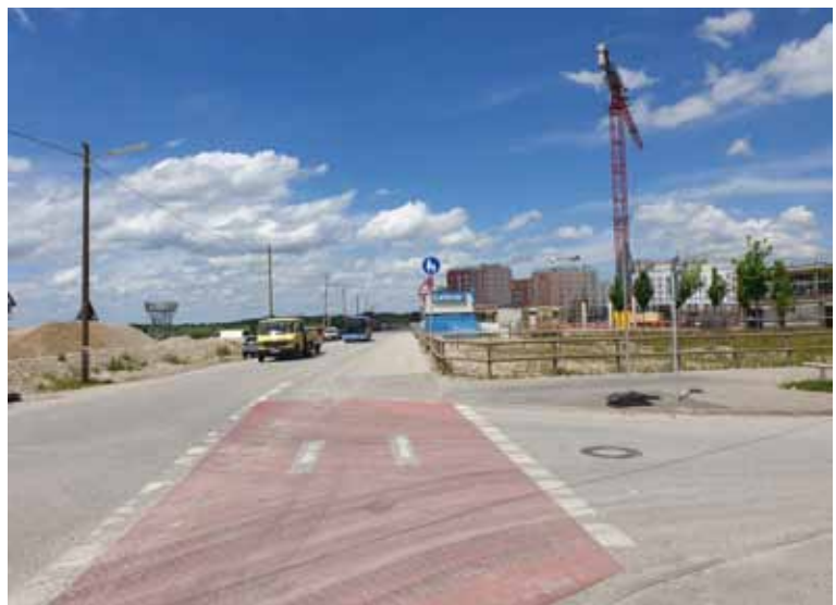
Zweirichtungsradweg endet abrupt
