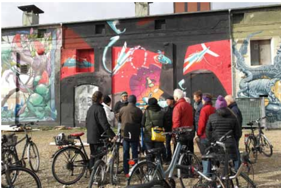
Blick auf den Riegel der ehemaligen Stallungen zur Tumbingerstraße
