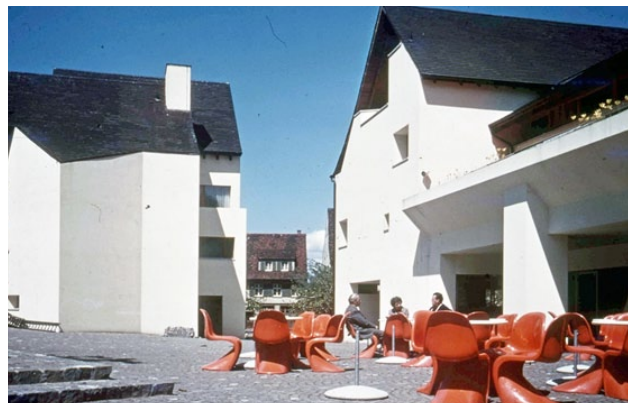
Abb. 1: Muttenz, Schweiz: Neues Dorfzentrum
