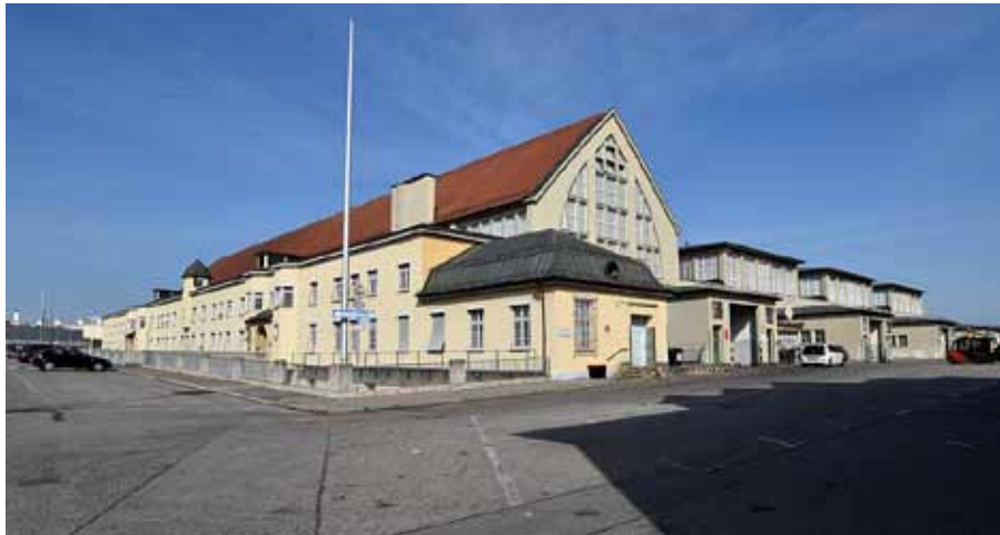
Abb. 2: Die Großmarkthalle von Südosten gesehen (2018).
