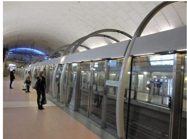
Paris: Bahnsteigtüren auf der Durchmesserlinie M 14, seit 1998/1999 in Betrieb
