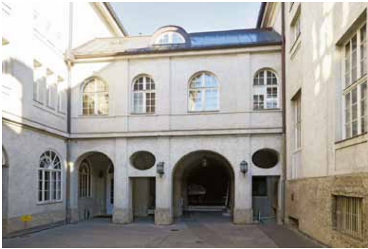
Abb. 2: Mozarteum: Verbindungstrakt mit Pausenfoyer im 1. Stock - vom Bundesdenkmalamt zum Abriss freigegeben
