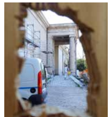
Abb. 5W: Guckloch im Bauzaun
