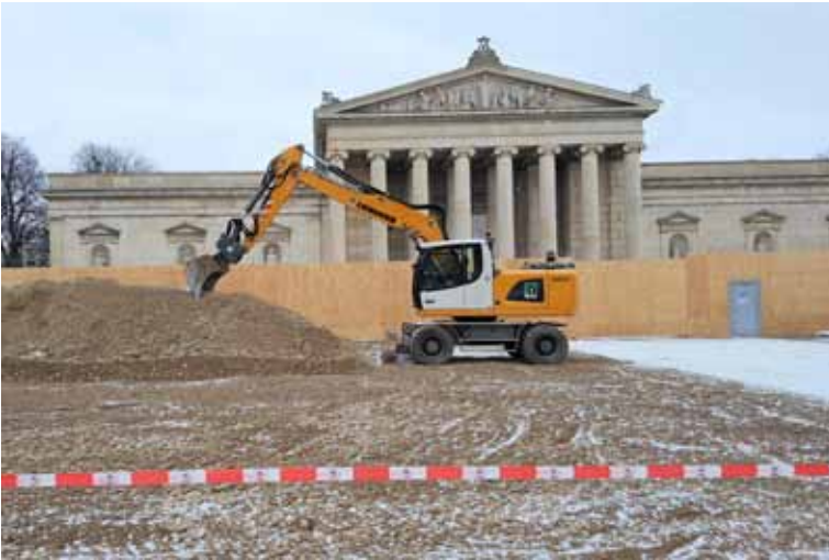
Abb. 2: Die Baustelle der Glyptothek am Königsplatz, Januar 2019
