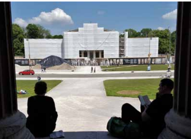
Abb. 4: Blick auf die Baustelle von den staatl. Antikensammlungen, Mai 2019
