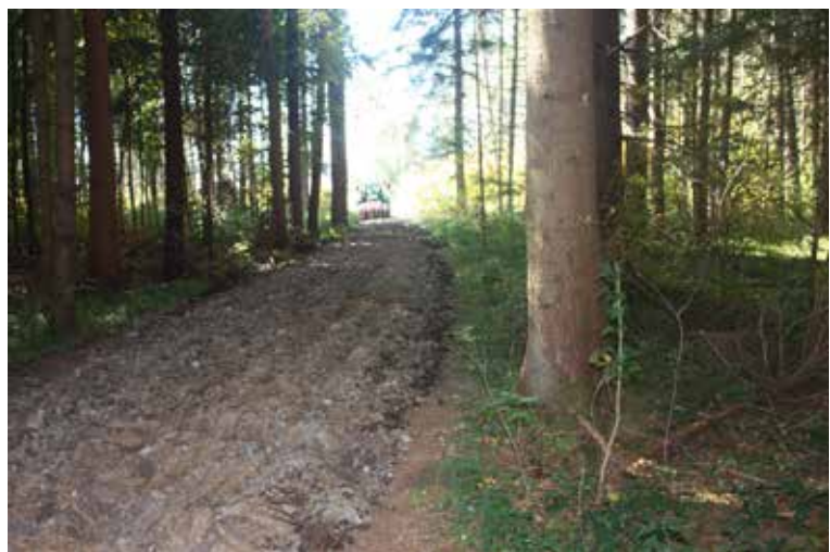
Barrierefreier Waldweg: erstmal die oberste Schicht lockern
