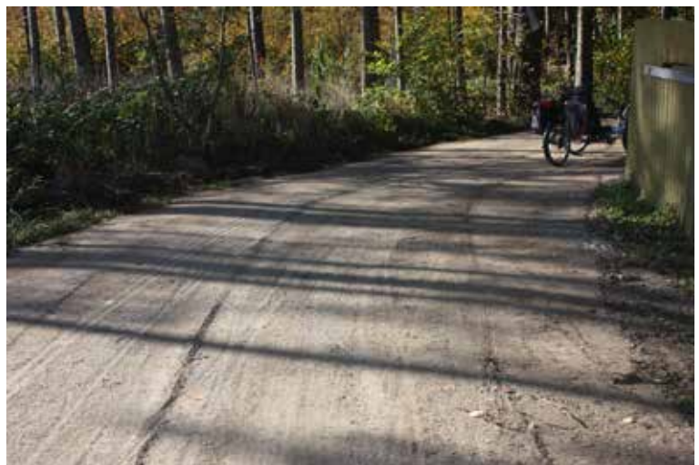
Barrierefreier Waldweg: Endzustand nach dem Plattenrüttler
