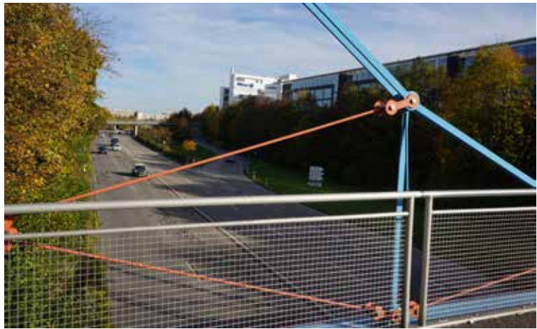
Brücke über die Ständlerstraße
