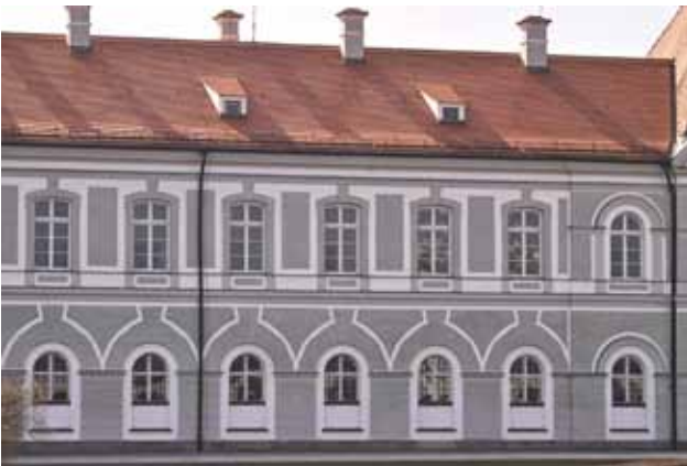
Blendarkaden im Erdgeschoss, Segmentbogenfenster im Obergeschoss und Archivolten im Risalit (rechts) am Marstallbau (Detail).
