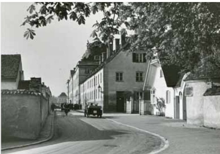
Blick aus der Maria-Ward-Straße auf den Klosterbau kurz vor dem Abriss im Jahr 1939.
