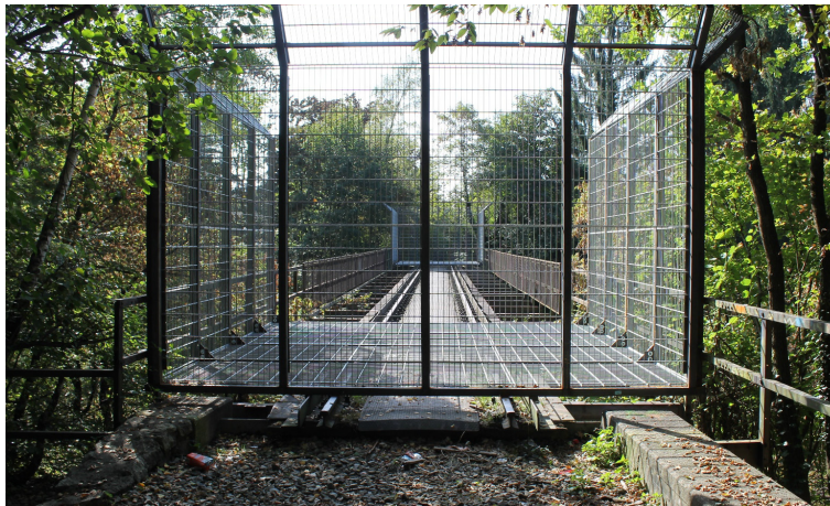
Aufgelassene Brücke der Isartalbahn in Pullach
