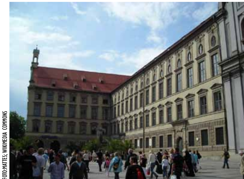
Alte Akademie, Fassade zur Neuhauser Straße, 2012
