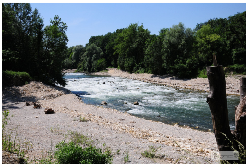
Die restaurierte Schwelle bei Achering (Juni 2015)
