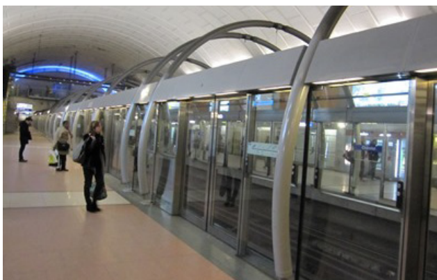
Paris: Bahnsteigtüren auf der Durchmesserlinie M 14, seit 1998/1999 in Betrieb
